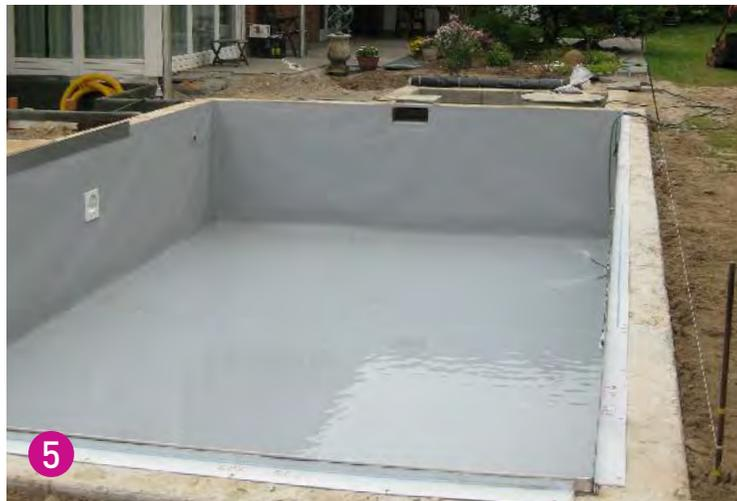
4 Die Schalsteine wurden mit einem Feinverputz versehen. Vor der Glasfront wird die gesamte Technik und Biofilter unterirdisch arrangiert.
